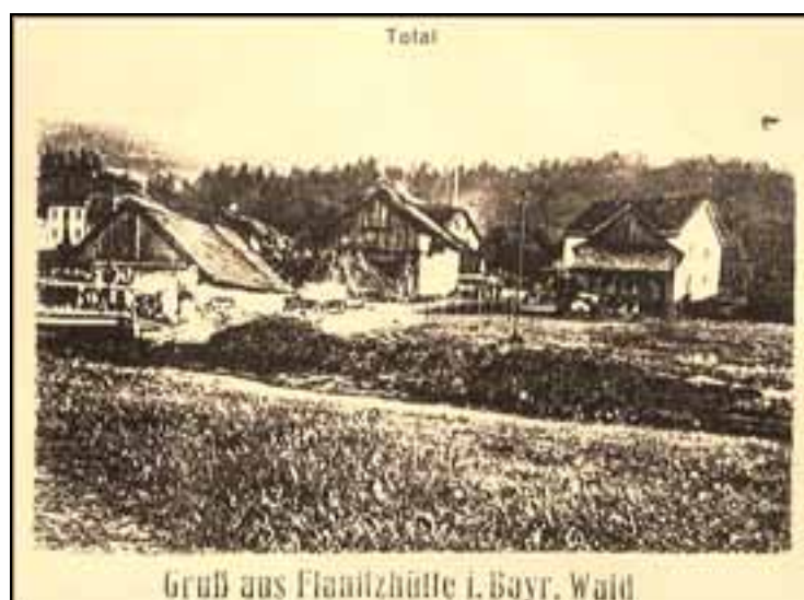
Abbildung 35: Ansicht der Flanitzhütte gegen Ende des 19. Jahrhunderts. Quelle: Max Schinabeck
