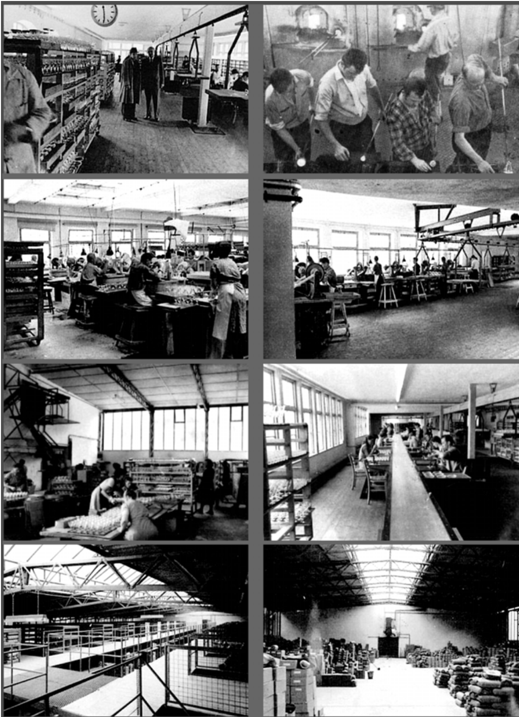
Abb. 44 Die neu renovierten lichtdurchfluteten Werkshallen
